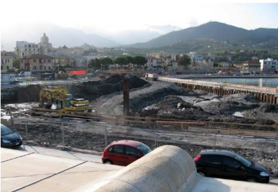
Si costruisce il muro di contenimento per il parcheggio interrato 2009
