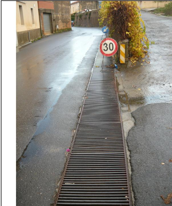
**Figura 2 – Particolare del rio in corrispondenza della S.P. Romana. La sezione d'alveo risulta fortemente inadeguata alla portata di riferimento.**
