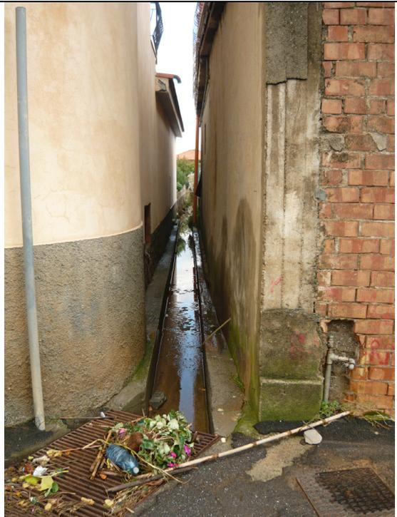
**Figura 3 – Particolare dello scolo nel tratto a valle della S.P. Romana. La sezione risulta idraulicamente inadeguata**
