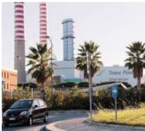
L'impianto della Tirreno Power
