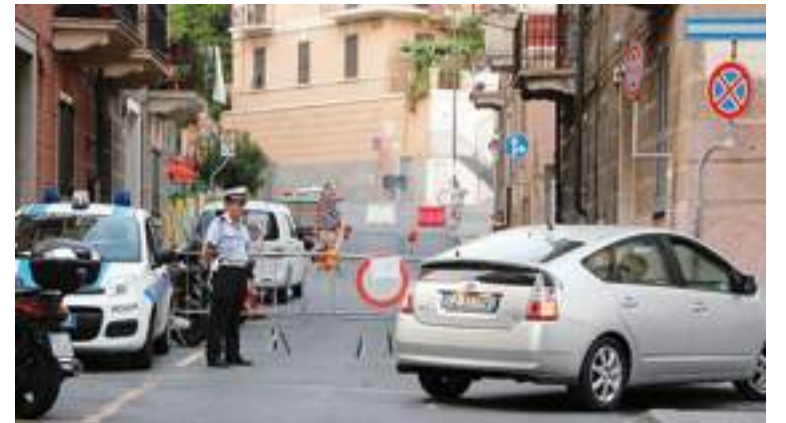
Chiusa al traffico via Mignone per il cedimento dell'asfalto
