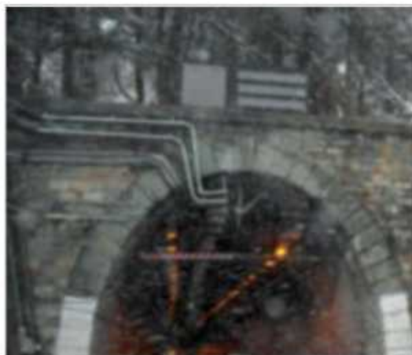
L'entrée du tunnel de Tende
